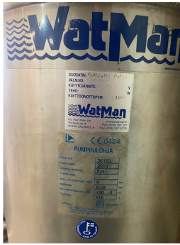
29. WATMAN VEDENSUODATIN, 110 LITRAA FeA sarjan suodattimet on suunniteltu raudan ja mangaanin sekä rikkivedyn poistoon humusvapaista vesistä.
