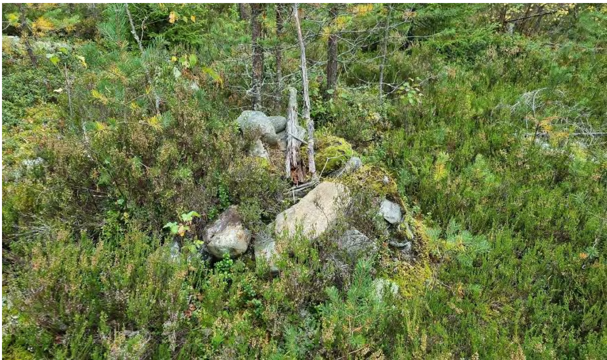
Kuva 17. Pyykin kiviperustus oli ladottu kolmion muotoon, joka oli osittain varvikon peittämä.
